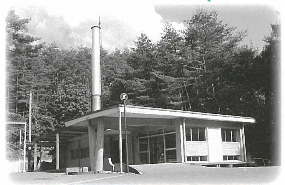
建設から40年が経過した火葬場
