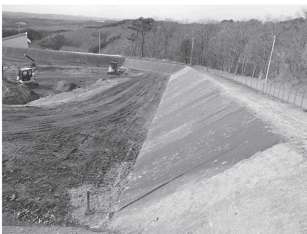
かさ上げ工事中の場内写真。 約2メートルかさ上げを行っています。
